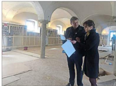
Im Gewölbekeller werden die Musikanten demnächst Kaffeepause machen: Verwaltungsleiterin Monika Seibold und Architekt Werner Pauli schauen sich auf der Baustelle um – damit Mitte April der Betrieb laufen kann, muss noch viel erledigt werden.
